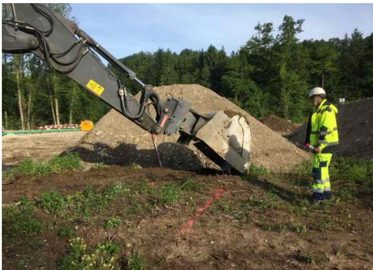
Abbildung 6: Neophytenbekämpfung im Rahmen des Projektes «Hochwasserschutz und Revitalisierung Emme, Wehr Biberist bis Aare»: Abtrag des mit Knöterich belasteten Bodens.
